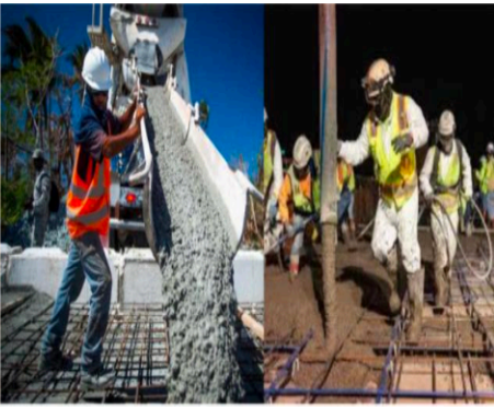
Công nhân đổ bê tông
